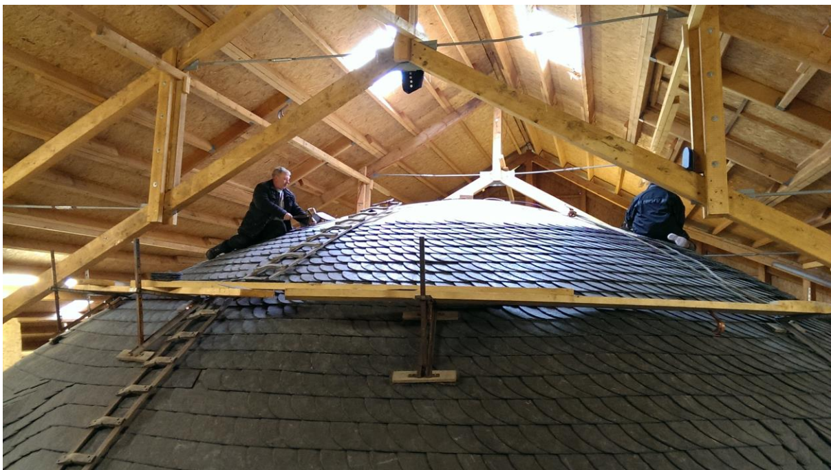
Abb. 16: Oberer Abschluss der Schieferdeckung.
